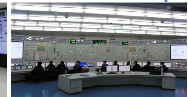
Gambar 4. Full Scope Simulator (FSS) HTR-PM untuk pelatihan operator di kota Weihai, 700 km dari Beijing.
