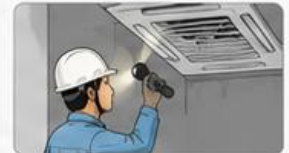
Pemeriksaan visual kebocoran & suara abnormal
