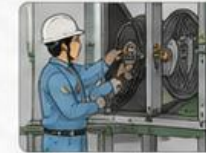
Pemeriksaan fan, motor, dan belt AHU
