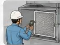
Pemeriksaan HEPA filter ( \Delta P & integritas)
