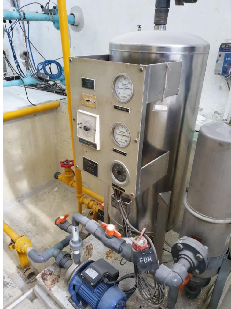
Sistem Demineralizer untuk Proses Pemurnian Air
