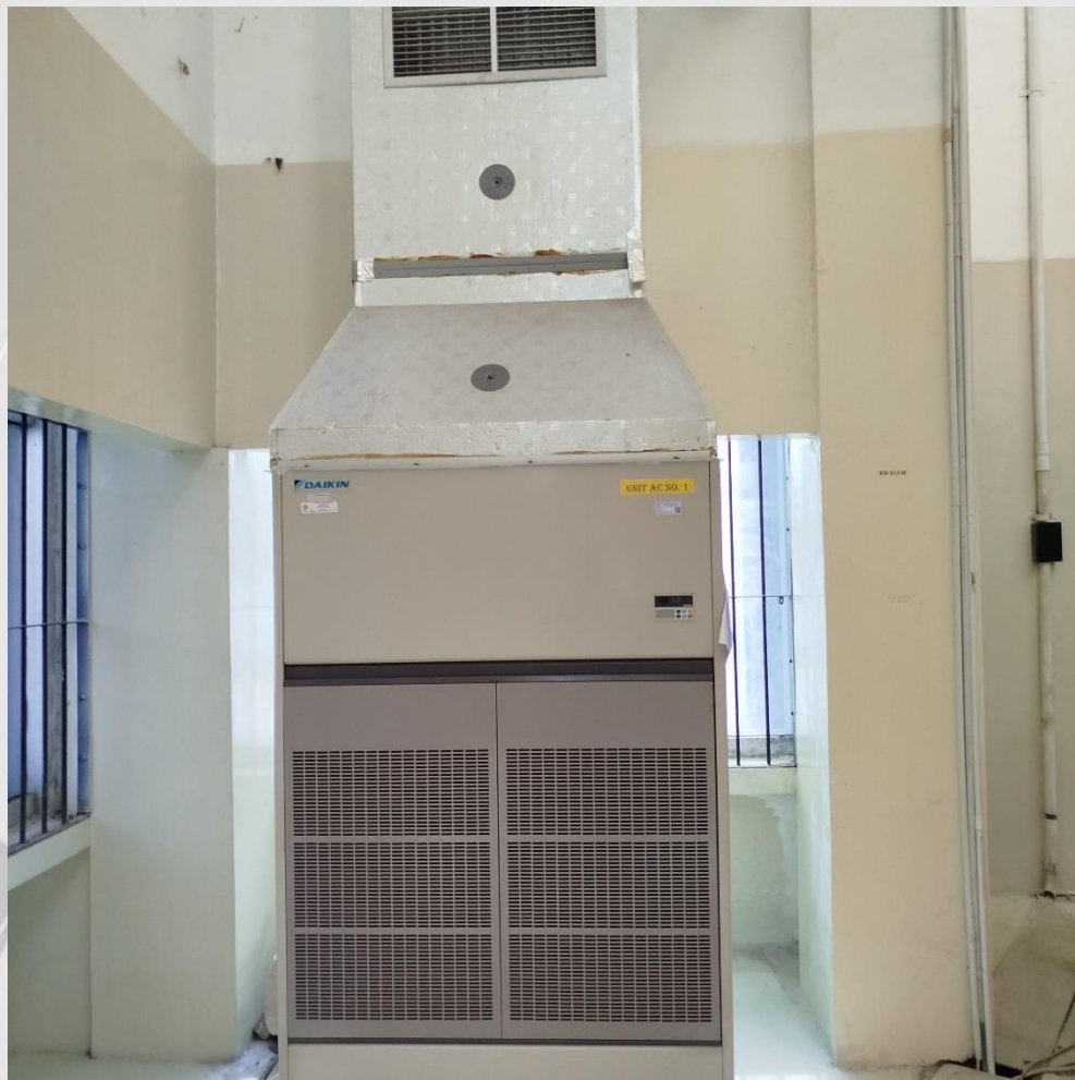
Gambar: AC 13 PK di hall reaktor
