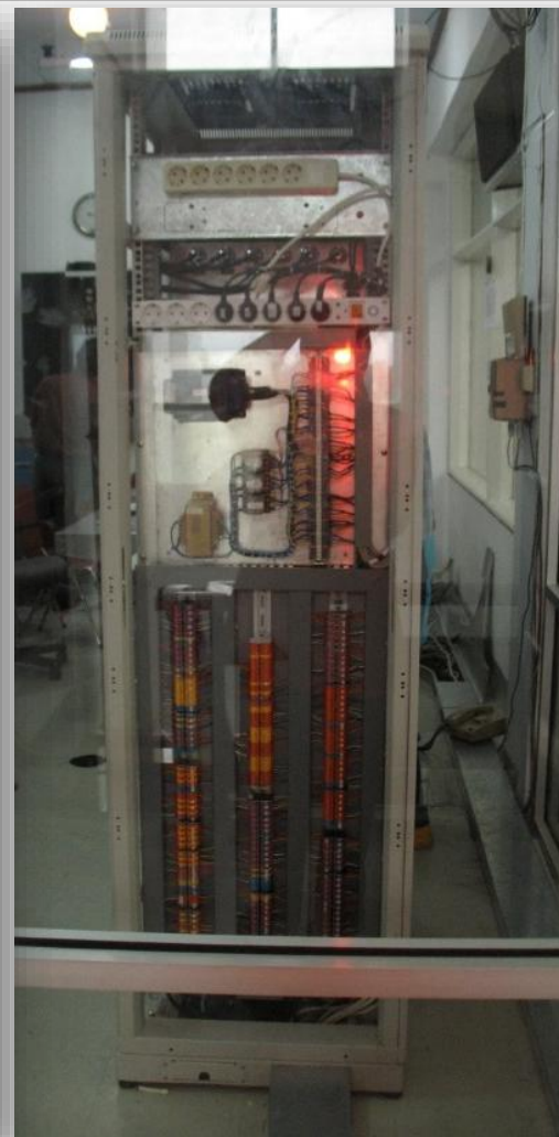
Interkoneksi dan pengkabelan SIK Terminal SR-4
