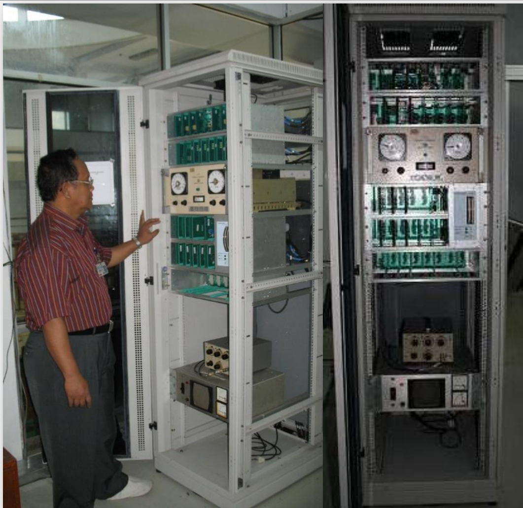
Interkoneksi dan pengkabelan SIK Terminal SR-4
